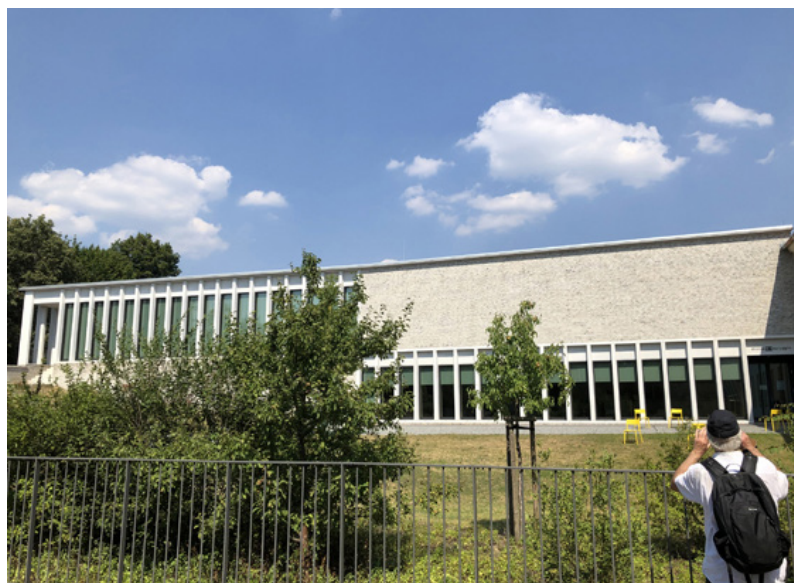
Der neue Anbau des Museums
